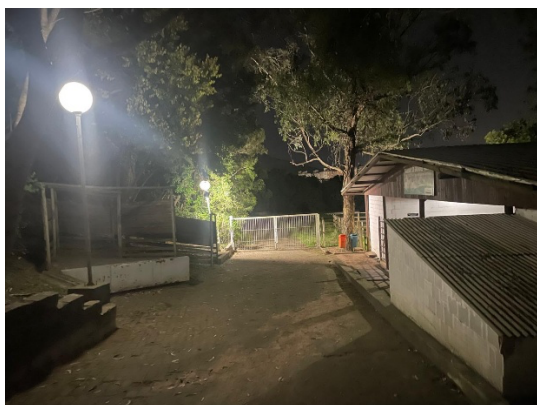
Legenda: Instalação de novos refletores no pavilhão de grandes animais
