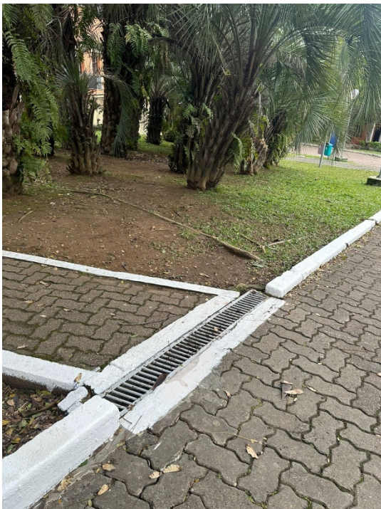
Legenda: Adequação do corredor de acesso para cadeirantes no Prédio 7
