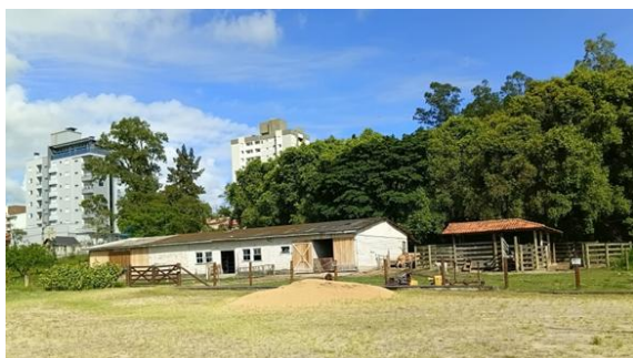
Fazenda Escola e estrutura destinada às práticas de Medicina Veterinária.
