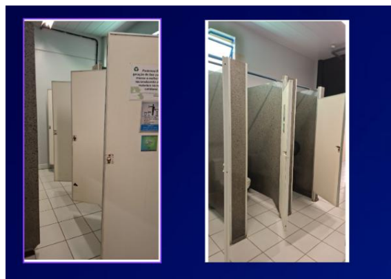
Adequações em banheiros e melhoria das condições de uso.
