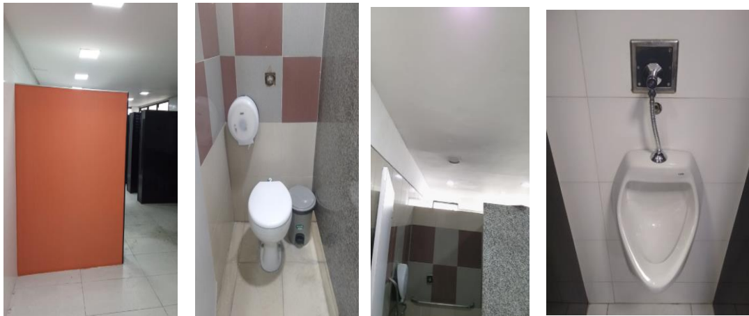
Melhorias e manutenção nos banheiros femininos e masculinos. Piedade.
