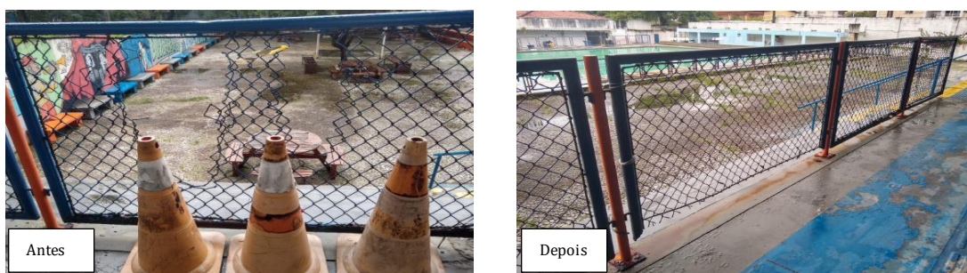
Reformas da estrutura das grades de proteção da quadrapoliesportiva, Piedade.
