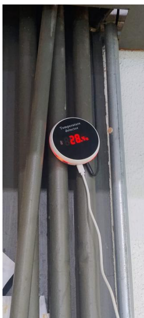
Figura 24 – Manutenção no sistema de aquecimento da piscina.
